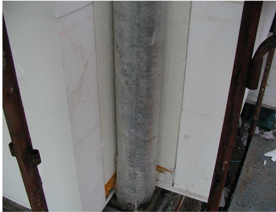
correzione ponte termico tubolari (Foto 9)
