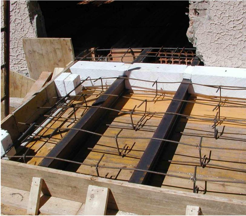
correzione ponte termico balconi (Foto 6)
