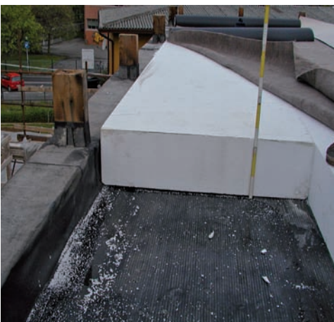
Isolamento copertura in EPS200 da 25cm.
